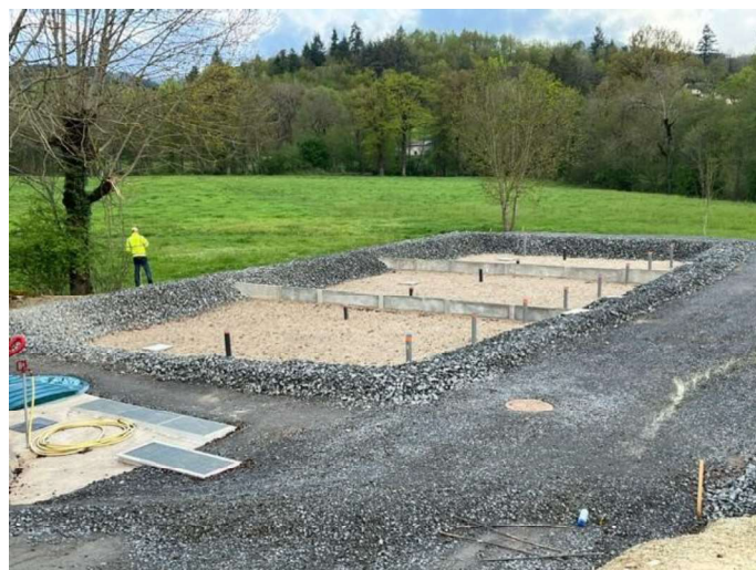
Nouvelle station d'épuration de Malvézy
